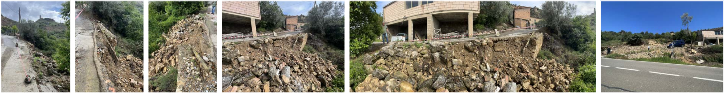
VISTES MUR ACTUAL
