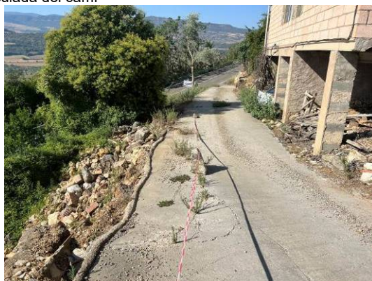
Paviment situat en fals en quan al recolzament
