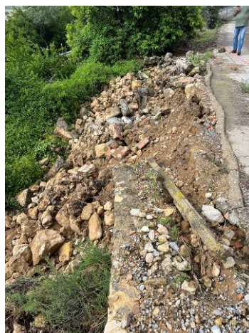
Fragments del mur col·lapsat
