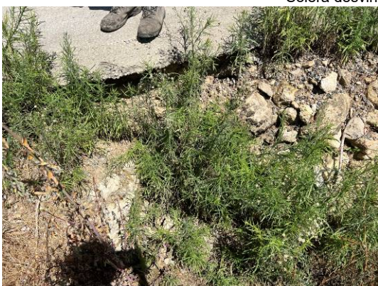
Paviment situat en fals en quan al recolzament
