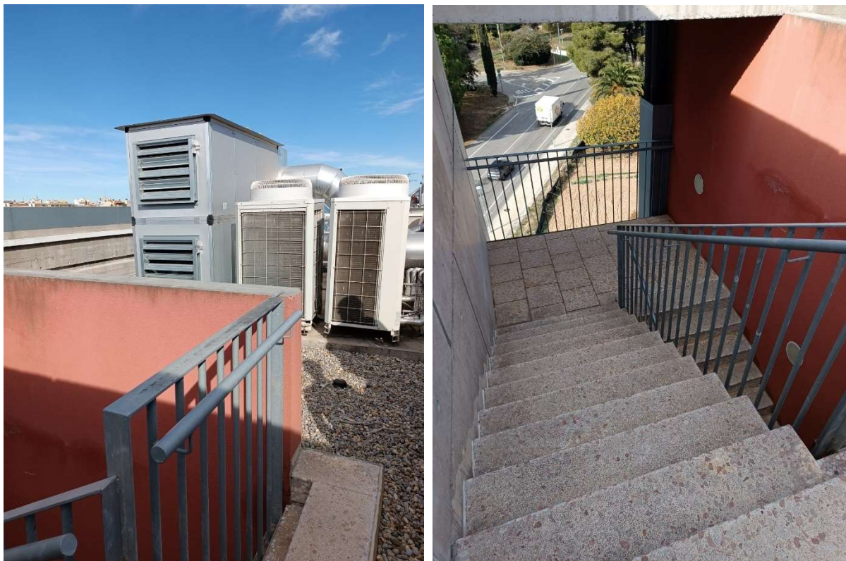
Fig. 20 Vista de l'escala d'accés a la coberta
