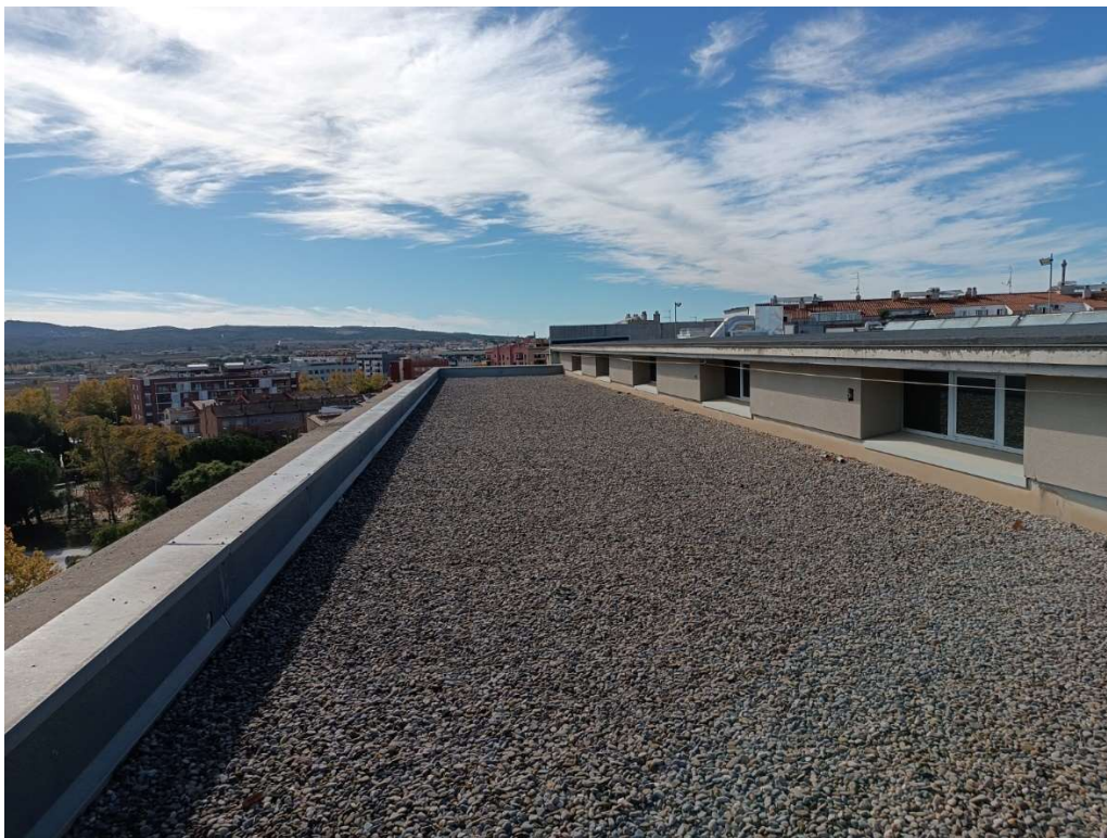
Fig. 22 Vista nivell inferior coberta (part de grava)
