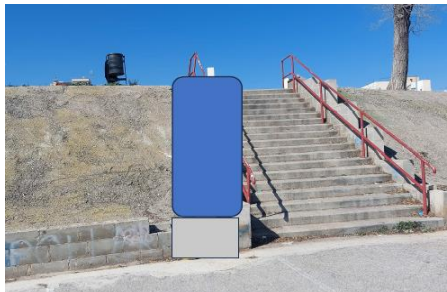
7) Ubicat a la part inferior de l'escala de l'aparcament (pantalla mòbil)
