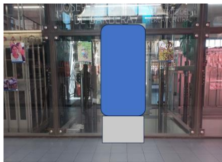
9) Caixa dels ascensors (entrada carrer Reding)
