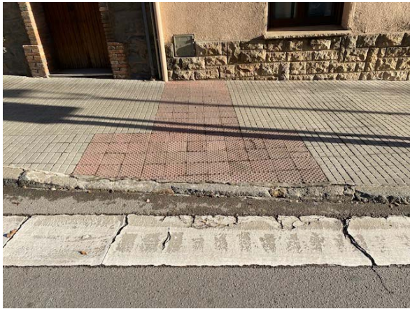
Vista al costat dret de zona l'actuació.
