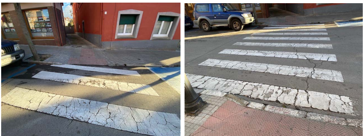
Vista al pas de vianants actual
