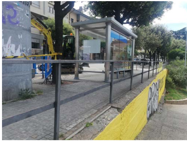
Vista al mur de la rampa d'accés a l'aparcament
