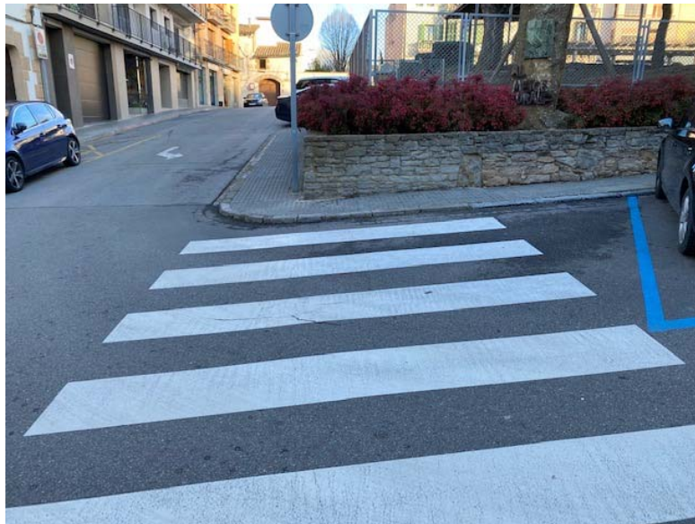
Vista al pas de vianants actual
