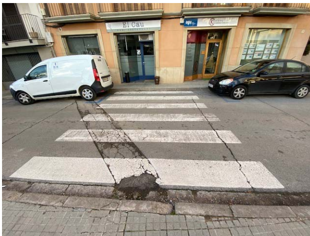
Vista al pas de vianants actual des d'un costat
