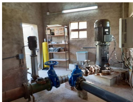
Figura 4: Interior Pou Sant Hilari nº2
