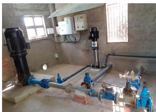
Figura 2: Interior Pou Sant Hilari nº1
