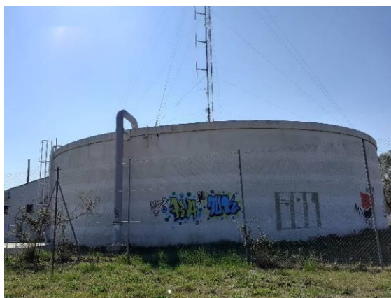
Figura 5: Exterior Dipòsit Sant Ermengol
