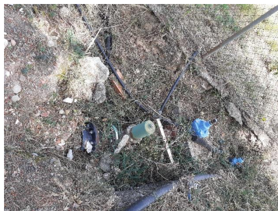
Figura 11: Vàlvules del dipòsit de la Rosa
