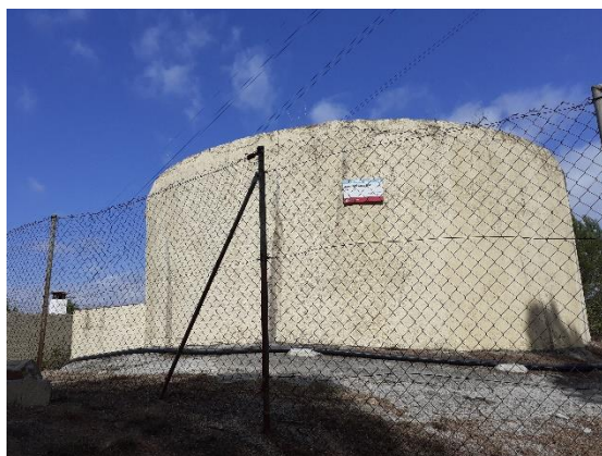
Figura 11: Exterior dipòsit de la Rosa
