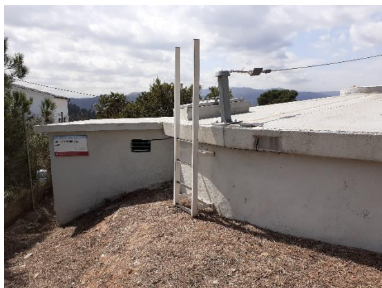
Figura 13: Exterior dipòsit del Liri
