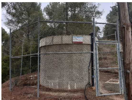
Figura 9: Exterior Dipòsit Sant Miquel
