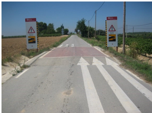
Plataforma reductora de velocitat en secció
