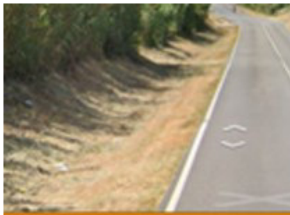
Cuneta no revestida
