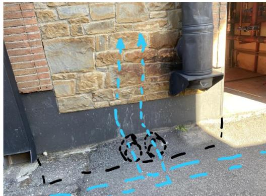
Entrada en la sala de calderas del pabellón se prevé entrar enterrado realizando 2 agujeros en la pared y una vez dentro hacer el cambio de tubería pex a acero negro.
