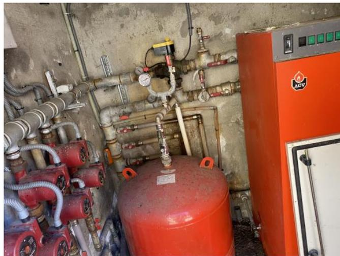
Sala calderas de la rampa de la calle Des Estudis, hay que eliminar la caldera eléctrica y sus elementos auxiliares y dejar únicamente las tuberías a partir de las dos válvulas de corte de la caldera que se ven detrás de la caldera.
