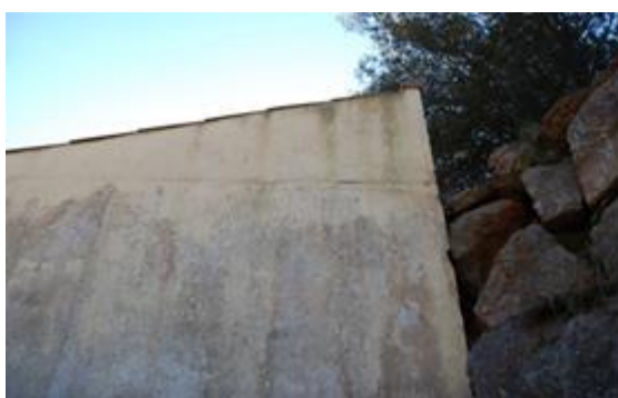
Nínxols costat sud oest
