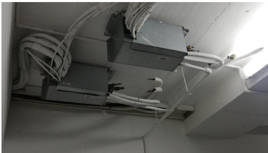
Distribuidors planta baixa: 2 Ut. amb tres sortides cada un
