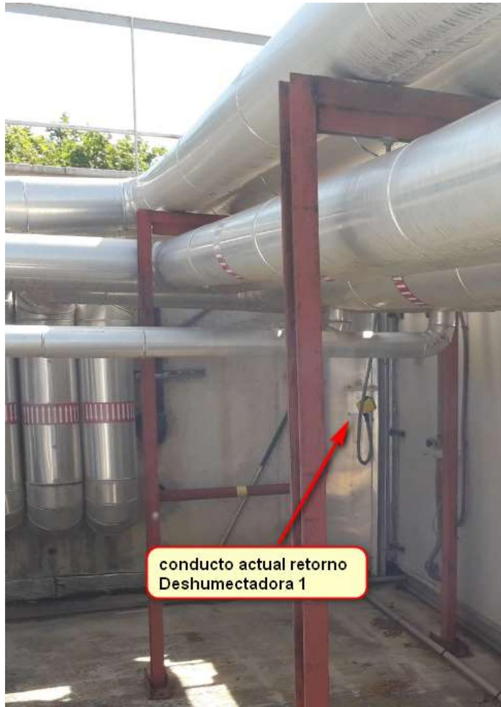
Imagen-4 Conducto actual retorno Zona técnica planta 1.
