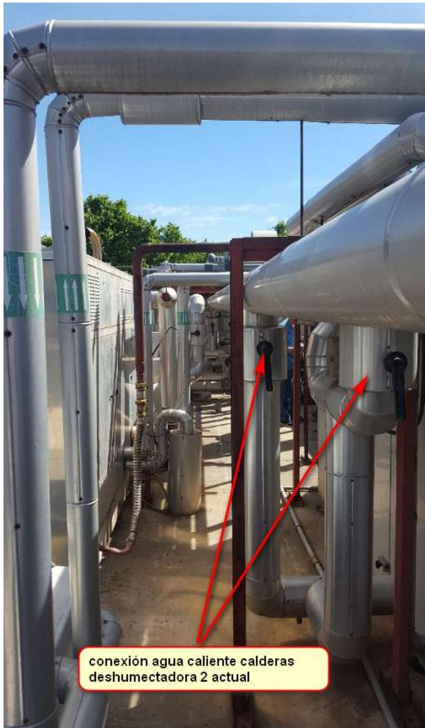
Imagen-7 conexión actual circuito agua caliente calderas deshumectadora -2
