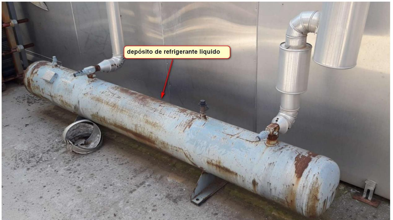
Imagen-17 - Equipos actuales a desmontar Zona técnica planta 1.
