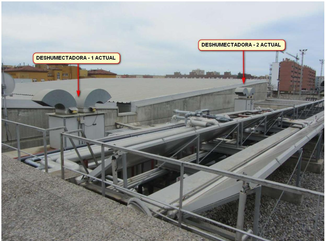
Imagen-12 - Deshumectadoras actuales a desmontar Zona técnica planta 1.
