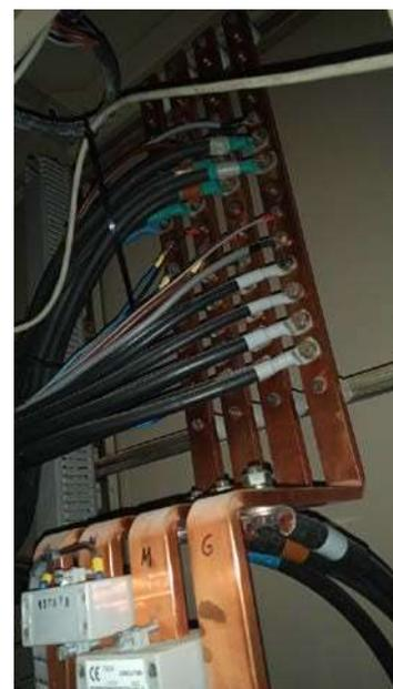
Fotografías del cuadro 04 de conexión de la línea general con identificación del espacio libre y embarrado para ubicar y conectar el nuevo elemento de protección magnetotérmica de una intensidad nominal máxima de regulación de 250 A, con incorporación de relé de protección diferencial.
