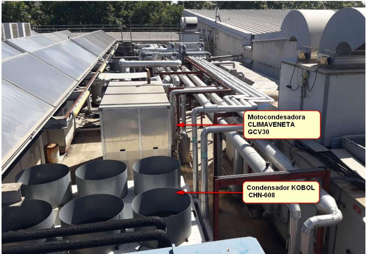
Imagen-13 - Equipos actuales a desmontar Zona técnica planta 1.
