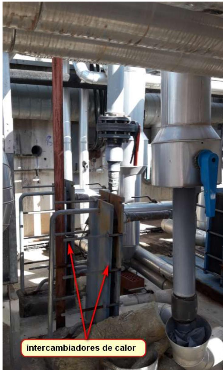
Imagen-15 - Equipos actuales a desmontar Zona técnica planta 1.
