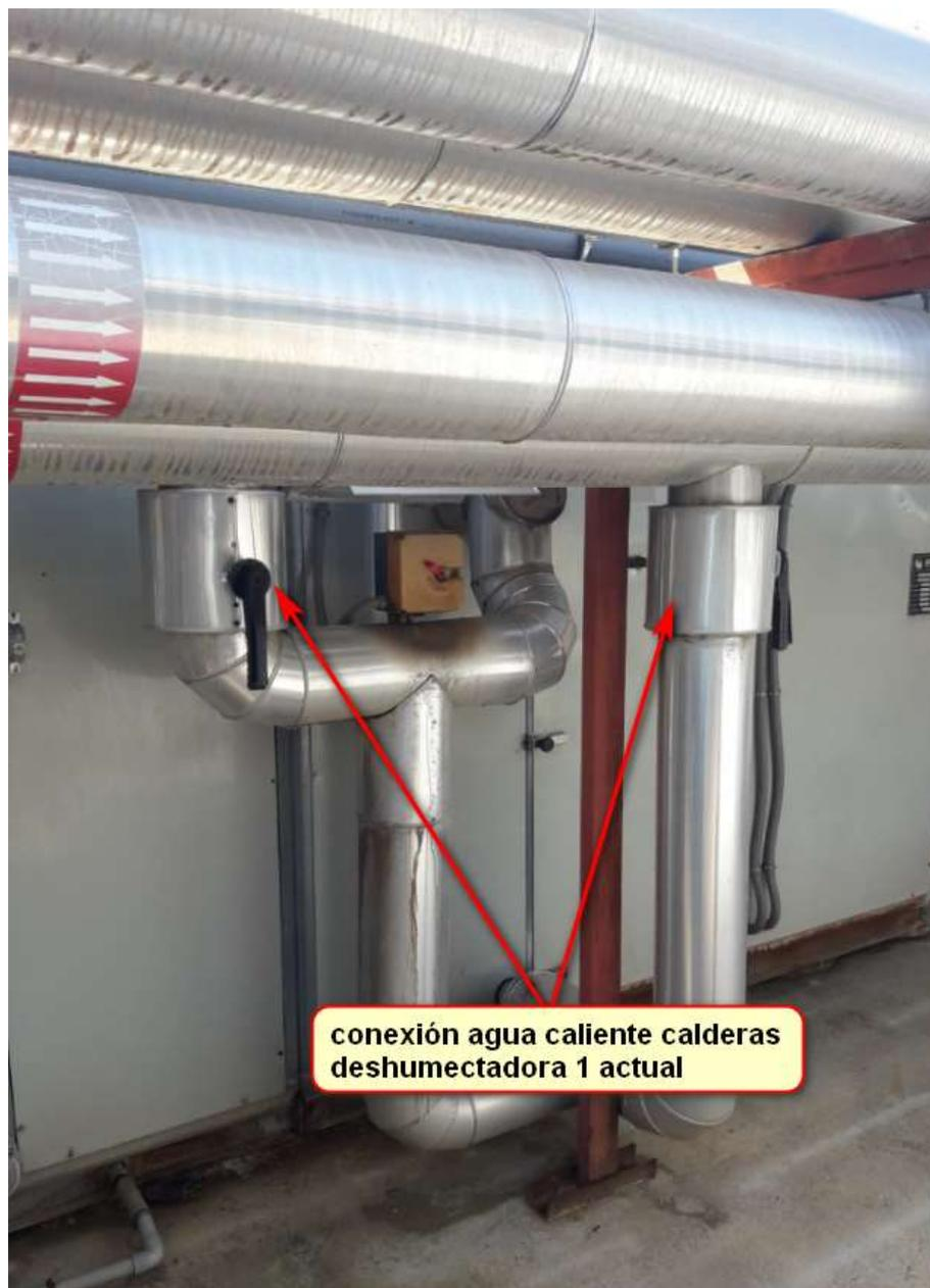
Imagen-6 conexión actual circuito agua caliente calderas deshumectadora -1
