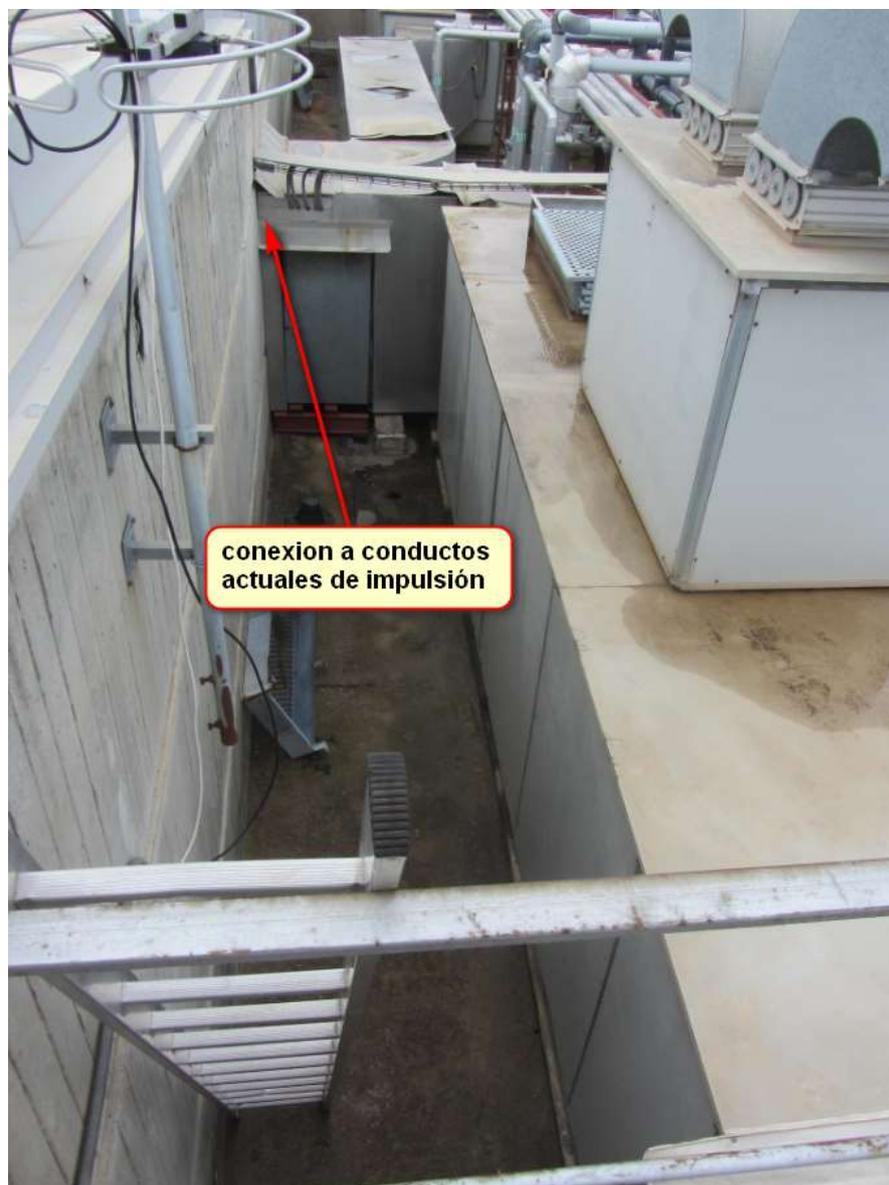
Imagen-2 Conductos actuales impulsión Zona técnica planta 1.
