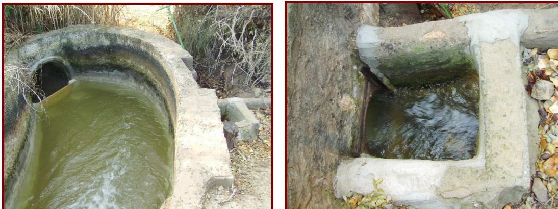
FIG 2. VISTA GENERAL DE LA CAPTACIÓ DEL CANAL D'URGELL TORNABOUS
