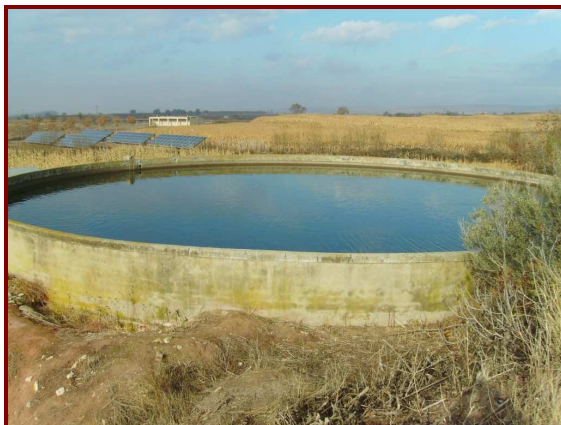
FIG 5. VISTA GENERAL DEL DIPÒSIT DESCOBERT DE TORNABOUS
