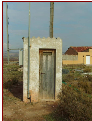
FIG 14. VISTA GENERAL DE LA CASETA DE DESINFECCIÓ XARXA LA GUÀRDIA
