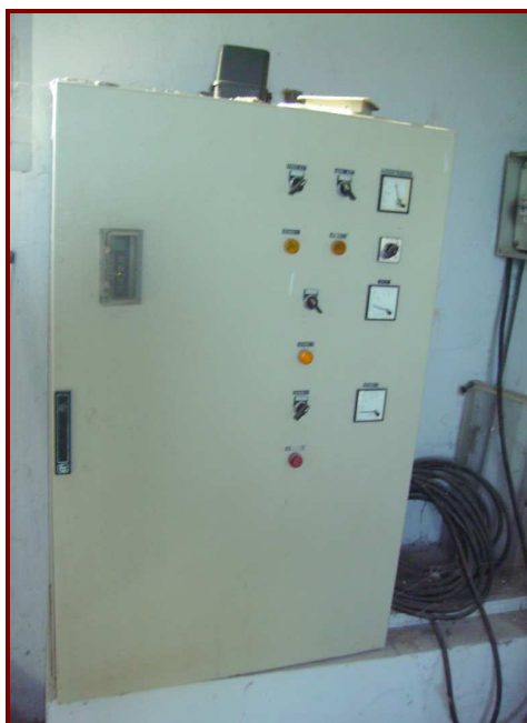
FIG 6. DETALL DEL QUADRE ELÈCTRIC I EL COMANDAMENT DE LES BOMBES
