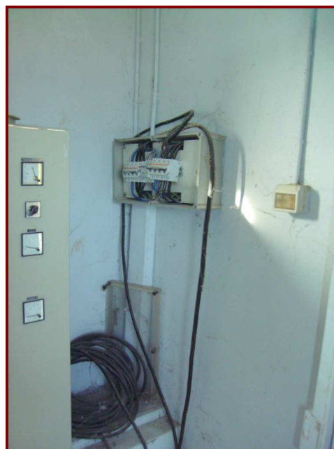
FIG 6. DETALL DEL QUADRE ELÈCTRIC I EL COMANDAMENT DE LES BOMBES
