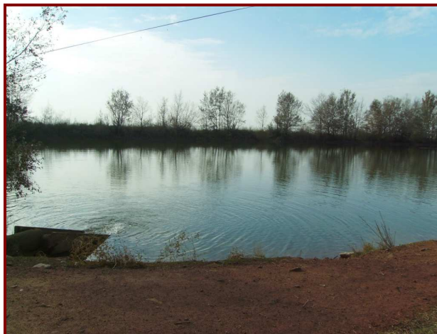
FIG 7. VISTA GENERAL DE LA BASSA DE RESERVA DE LA GUÀRDIA
