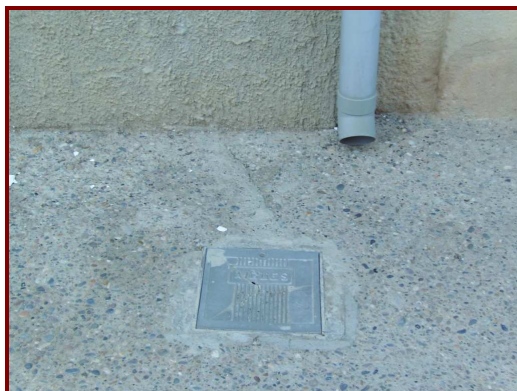
FIG 18. DETALL DE LES ESCOMESES DE TORNABOUS
