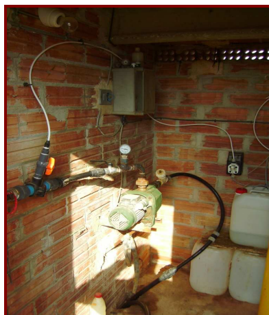
FIG 21. TANCs I BOMBES D'INJECCIÓ DE LES XARXES DE TORNABOUS I LA GUÀRDIA
