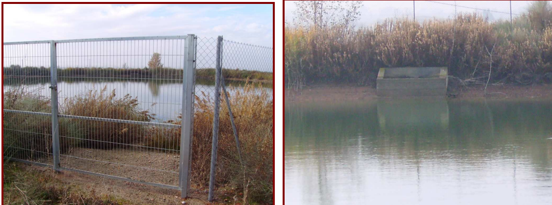
FIG 4. VISTA GENERAL DE LA BASSA DE RESERVA DE TORNABOUS
