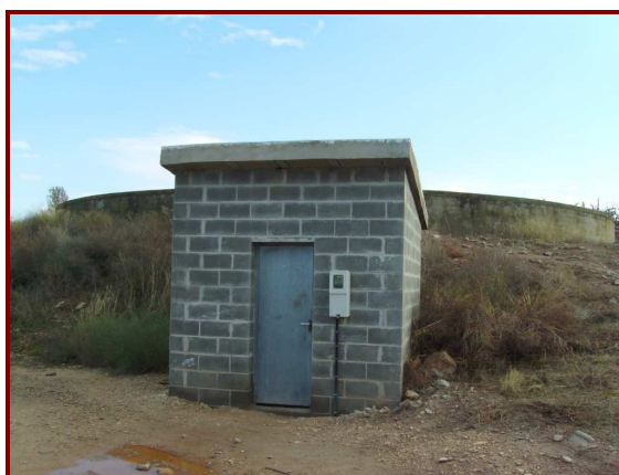
FIG 12. VISTA GENERAL DE LA CASETA DE DESINFECCIÓ XARXA TORNABOUS
