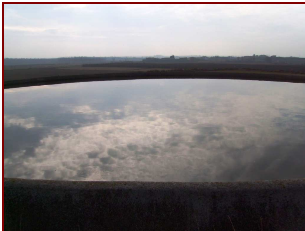
FIG 9. VISTA GENERAL DEL DIPÒSIT RODÓ DESCOBERT DE LA GUÀRDIA
