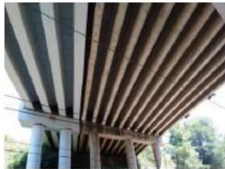
02. Vista inferior. Inspecció principal
