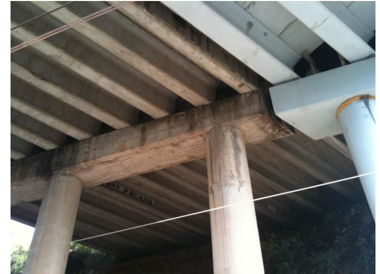
Pila costat Manresa
