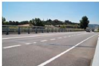
03. Vista superior PK descendent. Inspecció principal
