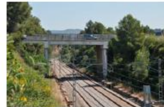
01. Alçat esquerra. Inspecció principal
