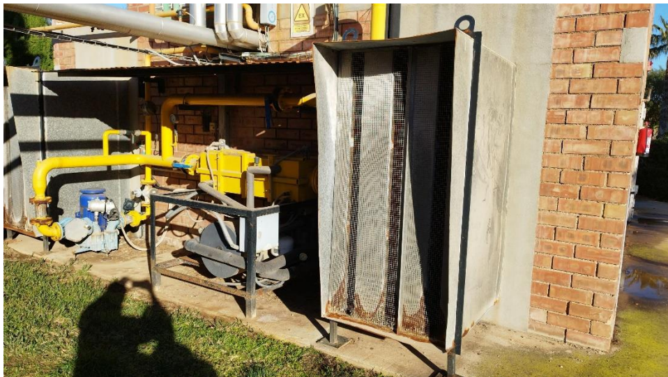
Silenciadors Estructura negra + xapa galvanitzat
