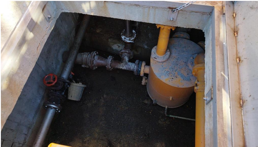
Arqueta condensats Neteja + pintura
