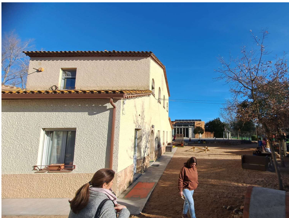
Façana lateral sud-oest
