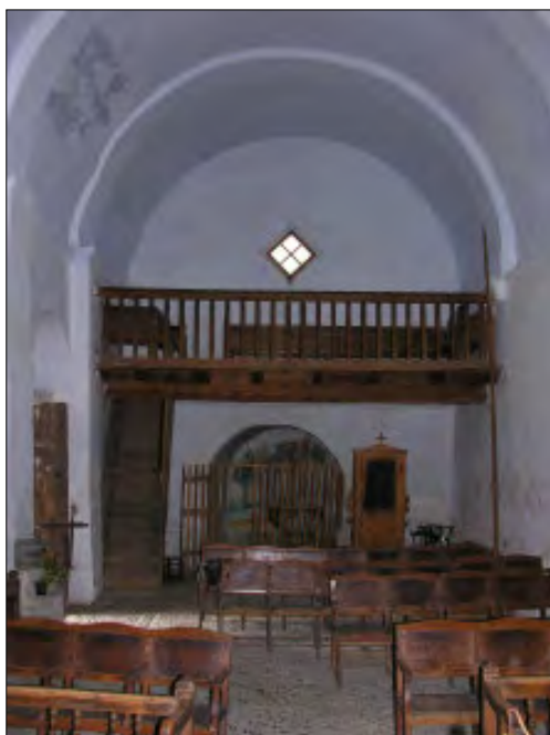
Fig. 16. Vista de l'extrem de ponent del temple. S'observa el cor, el sota cor i el baptisteri.
