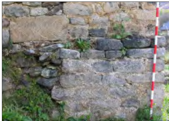
Fig. 5. Alguns dels carreus amb marques incises a la base del campanar.
