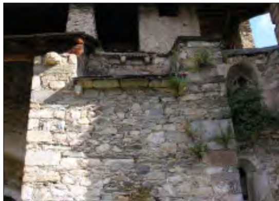
Fig. 7. Detall de les mènsules i altres elements que es troben sobretot a la façana de migdia del temple.
