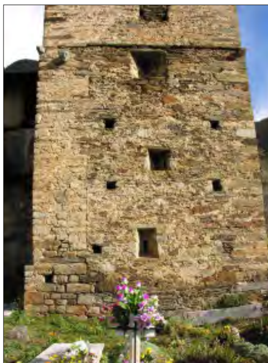
Fig. 9. Parament de migdia de la base del campanar. A la part superior es troben tres caparrons que sobresurten de la fàbrica.
