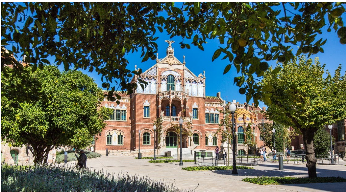
Jardins, patis i façana principal del pavelló d'Operacions
