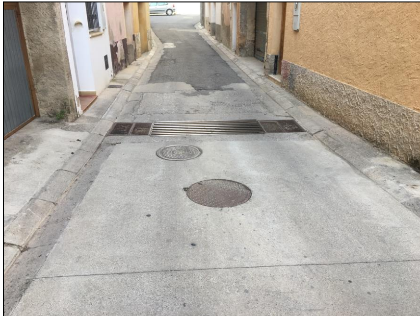
Foto 2. Detall punt problemàtic en xarxa de sanejament Carrer Tomàs Fontova
