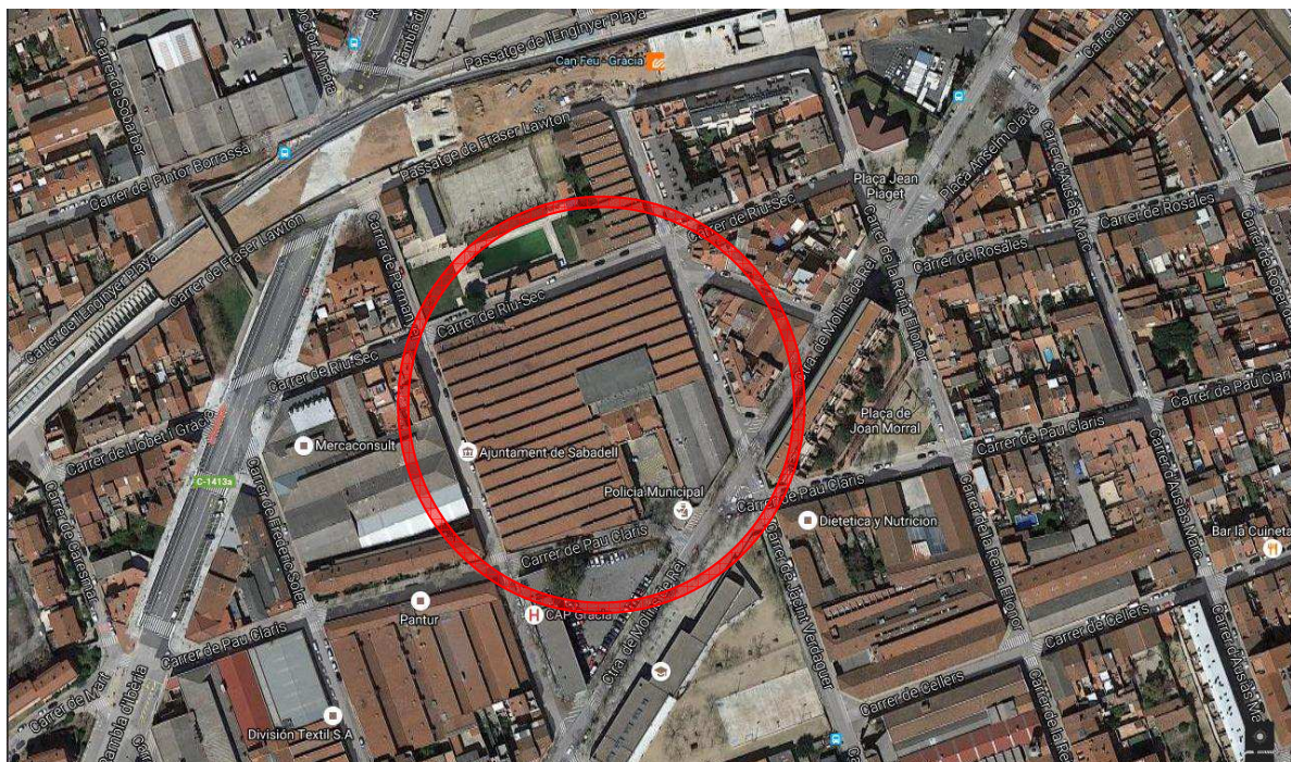
Reforma de la zona de recepció de la Policia Municipal, a l'edifici de Can Marcet
