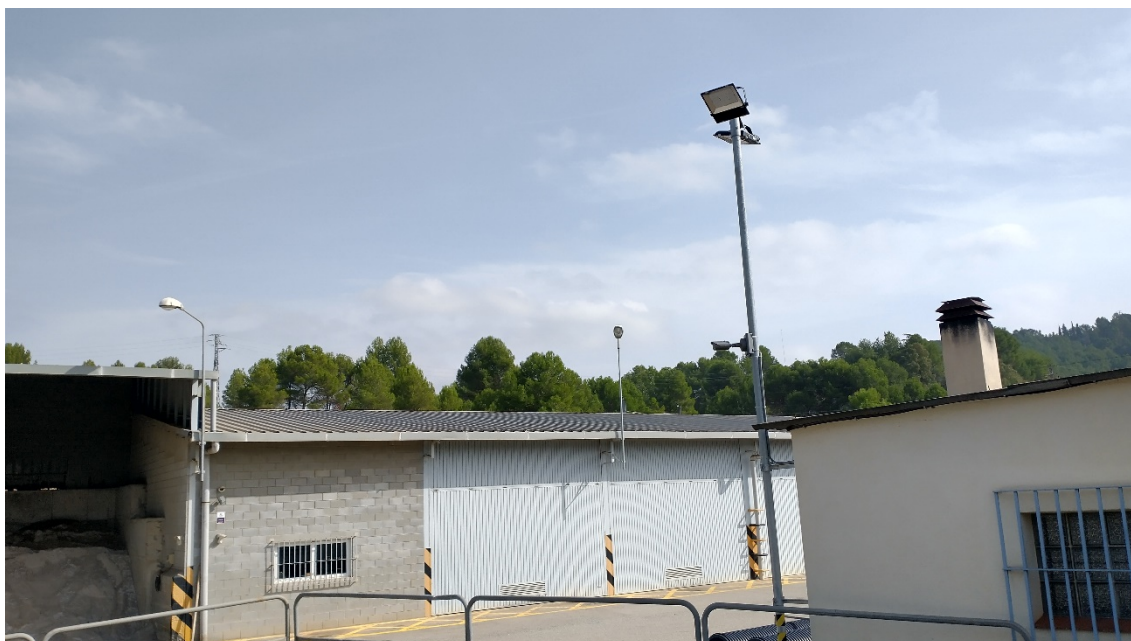
Imatge 1: Imatges de la ubicació de la instal·lació de generació
