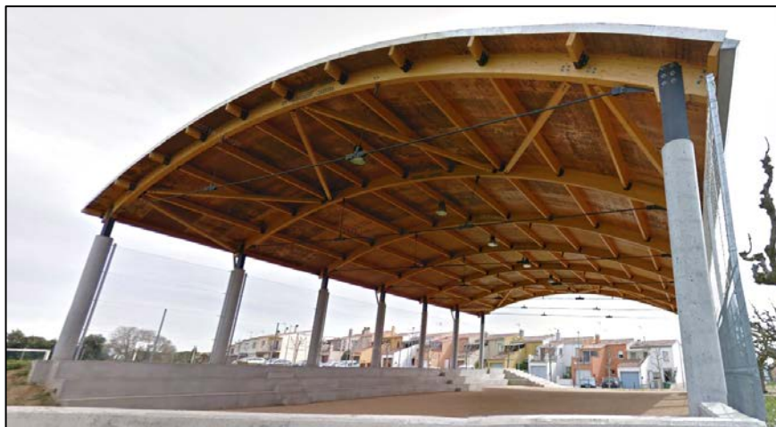
Imatge actual de la coberta
