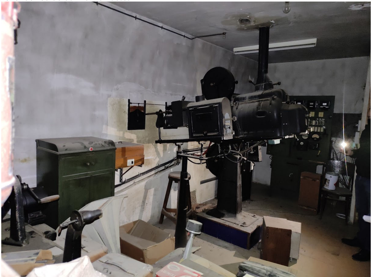
Zona tècnica actual ment en desús
