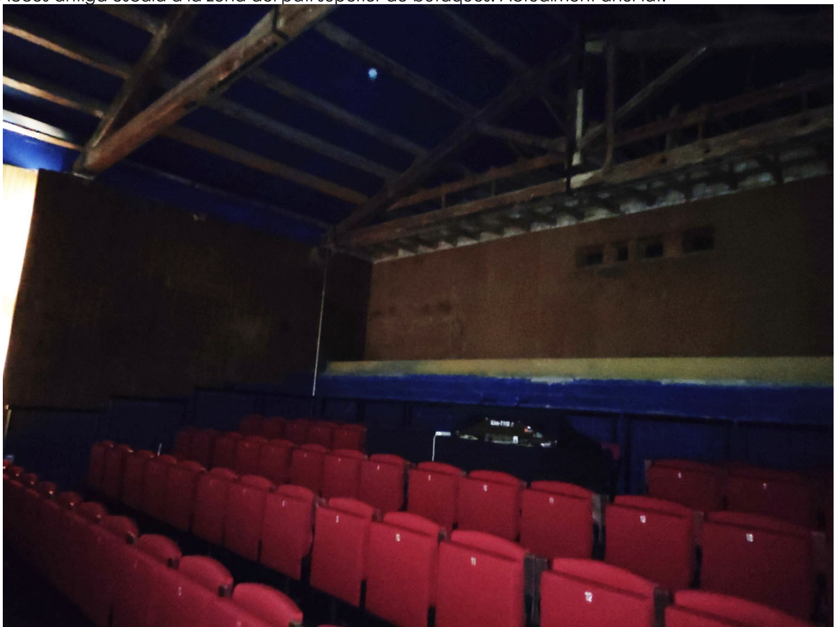
Ultimes fileres de grades, amb la zona tècnica darrere.
