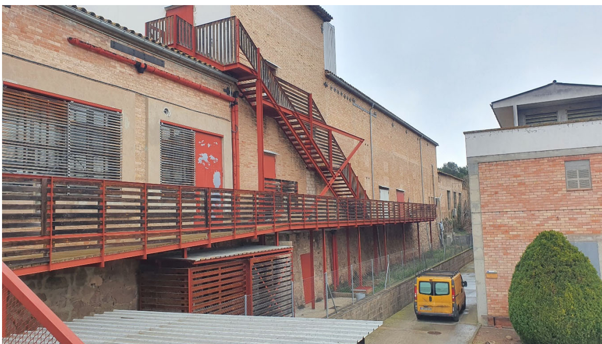
Vista de la façana sud del teatre.
