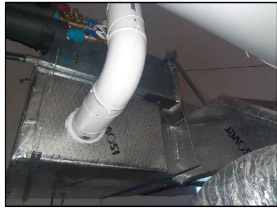
EQUIP CONDUCTES EXISTENT A DESMUNTAR
