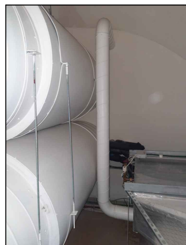
CONNEXIÓ A CONDUCTE EXISTENT D'APORTACIÓ
