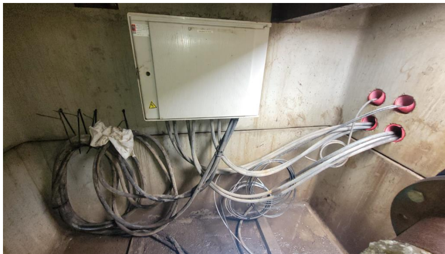
Il·lustració 4 Connexió de subministrament elèctric a la bomba de l'interior de la captació
