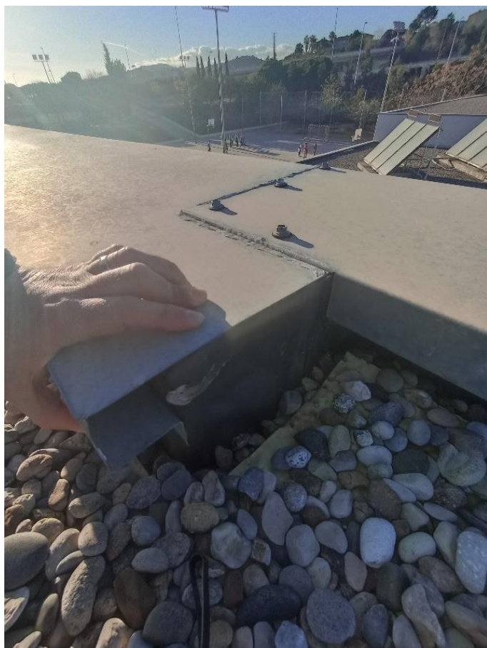
Fotografia P1.43 (Transició cobremurs 30 i 50 cm)
