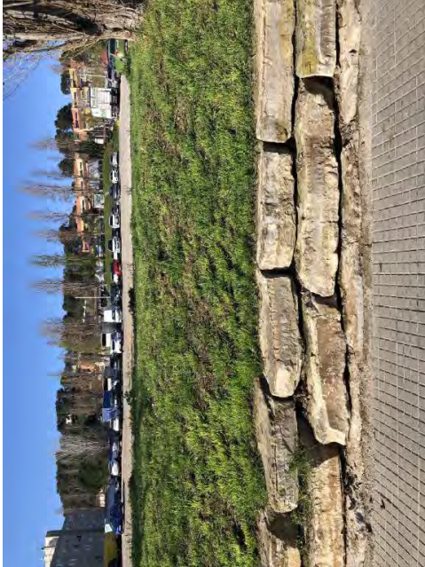
① Mur existent de pedra
