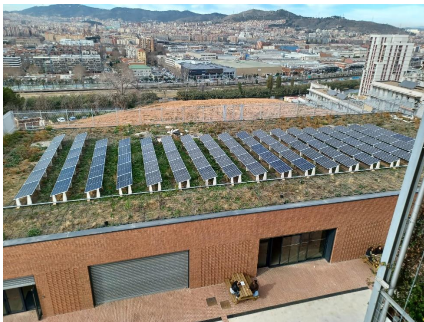
Actual estat de la coberta verda Centre Formació Marie Curie
