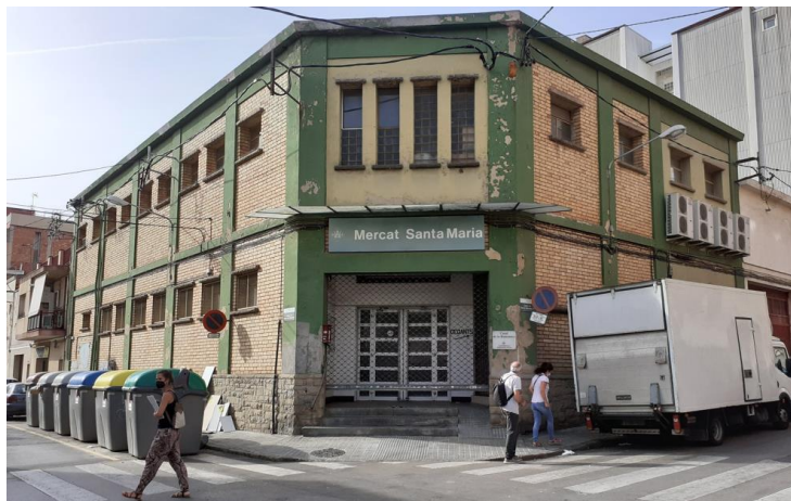
Foto 01. Façana. Accés cantonada
