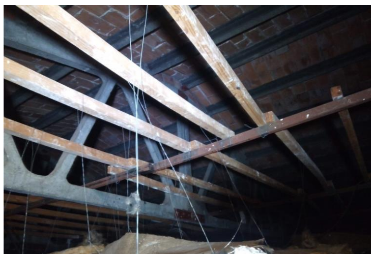
Foto 03. Estructura coberta. Encavallada formigó
