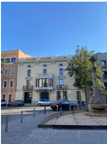
Façana principal de l'edifici després de la rehabilitació de l'any 2021
