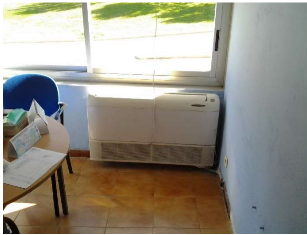
Imatge 2 i 3. Vista general dels evaporadors de la instal·lació de climatització de la zona d'oficines de planta primera. A l'esquerra, evaporador de l'oficina, i a la dreta evaporador del despatx de direcció, on s'observa el mal estat d'aquests.
