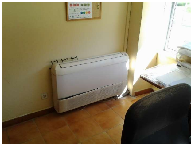
Imatge 2 i 3. Vista general dels evaporadors de la instal·lació de climatització de la zona d'oficines de planta primera. A l'esquerra, evaporador de l'oficina, i a la dreta evaporador del despatx de direcció, on s'observa el mal estat d'aquests.
