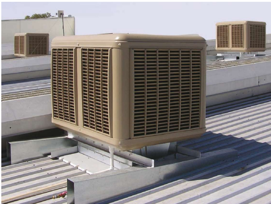
Imatge 10. Vista imatge d'exemple d'un evaporatiu i de l'estructura de suport per adaptar-lo a una coberta inclinada.
