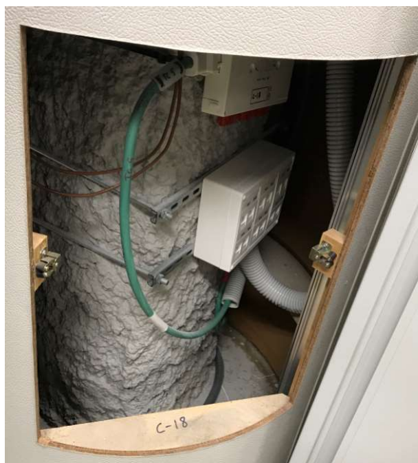
F5. Fotografia del registre per als mecanismes a instal·lar en interior de revestiment de pilar (punt de consolidació) i tipus de suports a utilitzar per tal de no comprometre la protecció al foc dels pilars.
