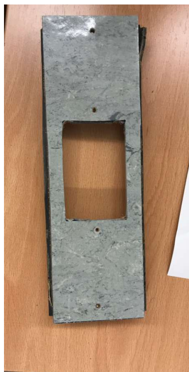
F3.Fotografia de la perforació a la tapa del carril existent per al pas de cablejat
