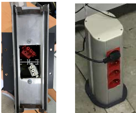
Fotografia columna porta mecanismes mecanitzada sobre tapa de canalització a terra amb connectors ràpids Ensto.
