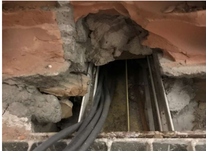
F1.Fotografia pas de connexió entre pati tècnic i carril metàl·lic existent
