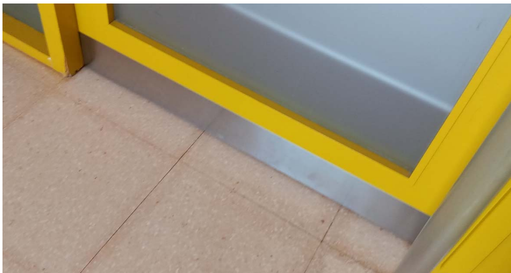
Fotografia 14: Detall acabat de les portes reparades
