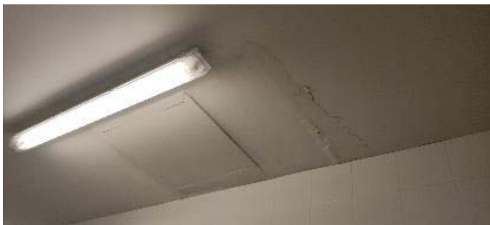
Filtracions a les aules i passadís de Planta 2ª
