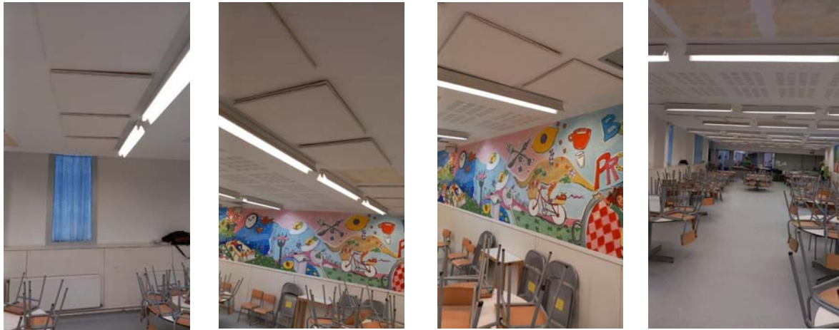
Plaques fono absorbents del menjador
