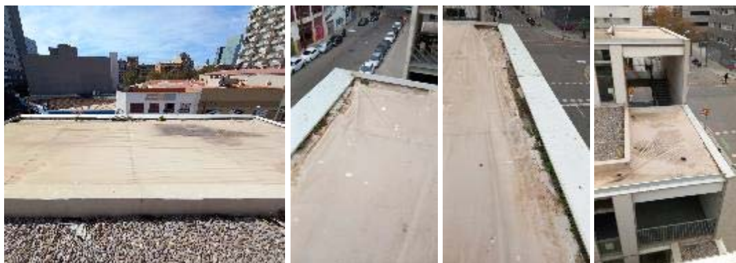
Retracció de la làmina impermeabilitzant
