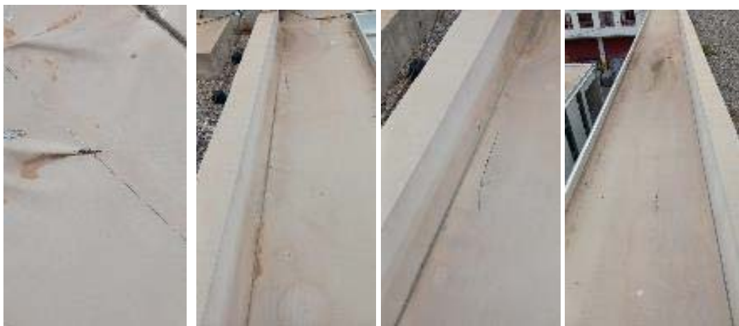
Retracció de la làmina impermeabilitzant
