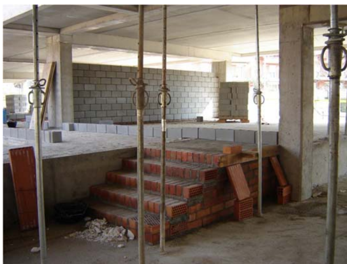
Fotografia 4: Imatge de la zona de deformacions, en fase d'obra.
