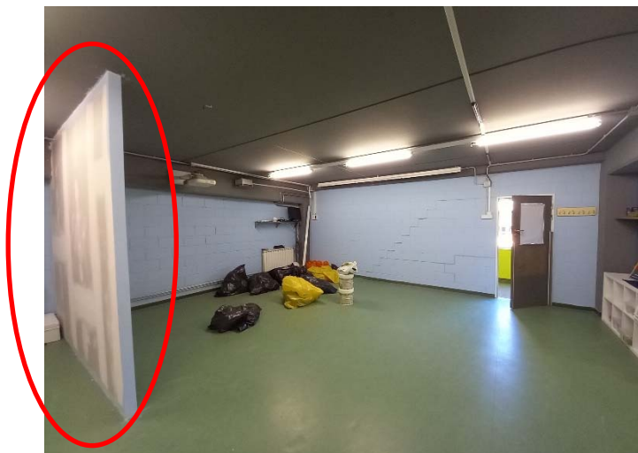
Fotografia 6: Envà de placa de guix a desmuntar
