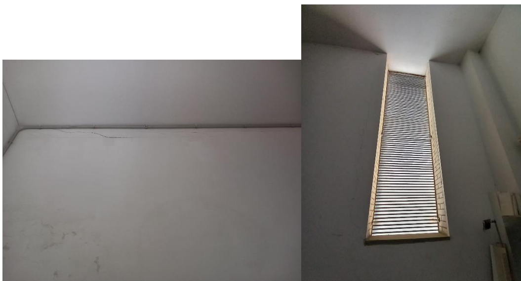
Fotografies de l'escala a nivell d'accés a coberta
