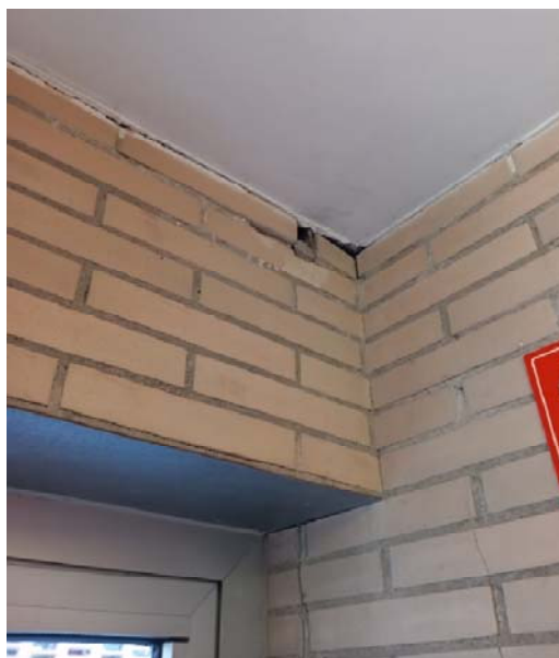
Fotografia 16: Fissures Interiors
