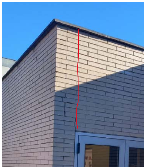
Fotografia 17: Formació de junta de dilatació
