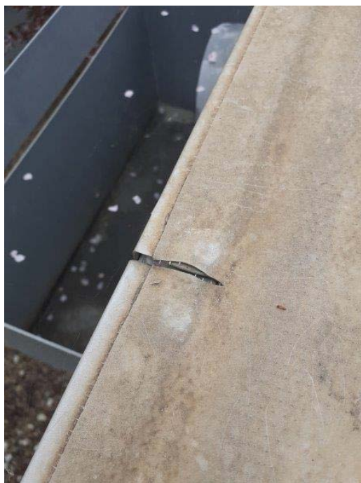
Detall cobertura mur amb la mateixa làmina.
