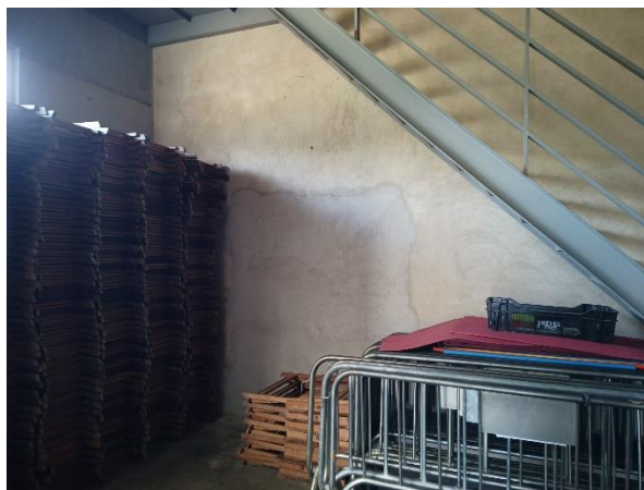
Il·lustració 12 - Zona instal·lació inversors i quadre
