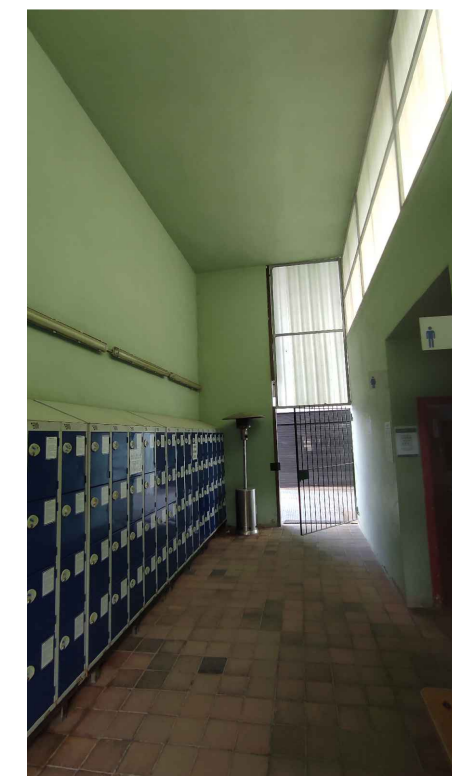
IMATGES DELS LAVABOS
