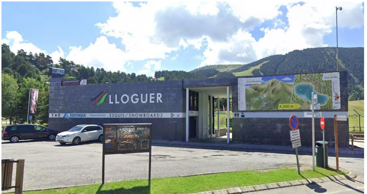
Imatge exterior de l'edifici
