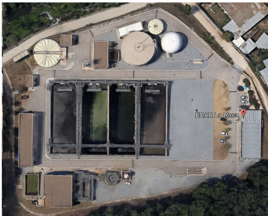
Figura 1. Vista aèria de l'EDAR La Roca del Vallès (Font: Google Maps).
