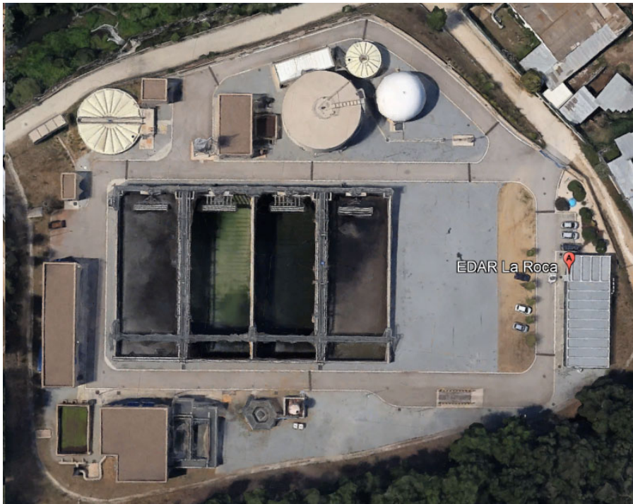
Figura 1. Vista aèria de l'EDAR La Roca del Vallès (Font: Google Maps).
