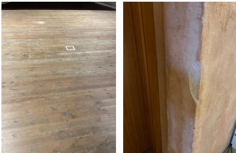
Parquet a polir i envernissar i arrebossat a arranjar
