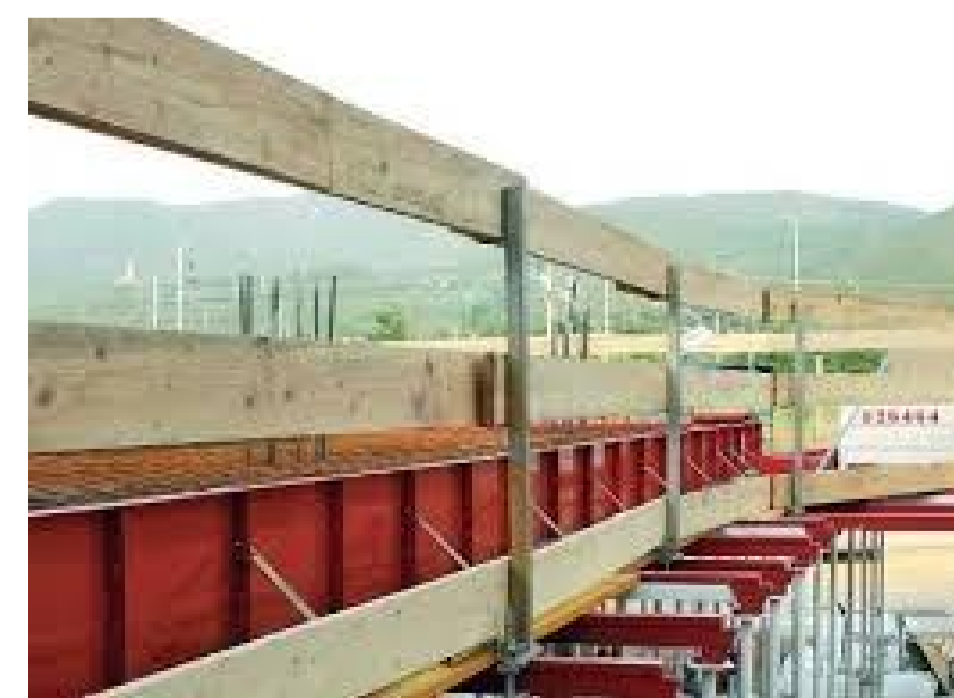
Barana de seguretat
