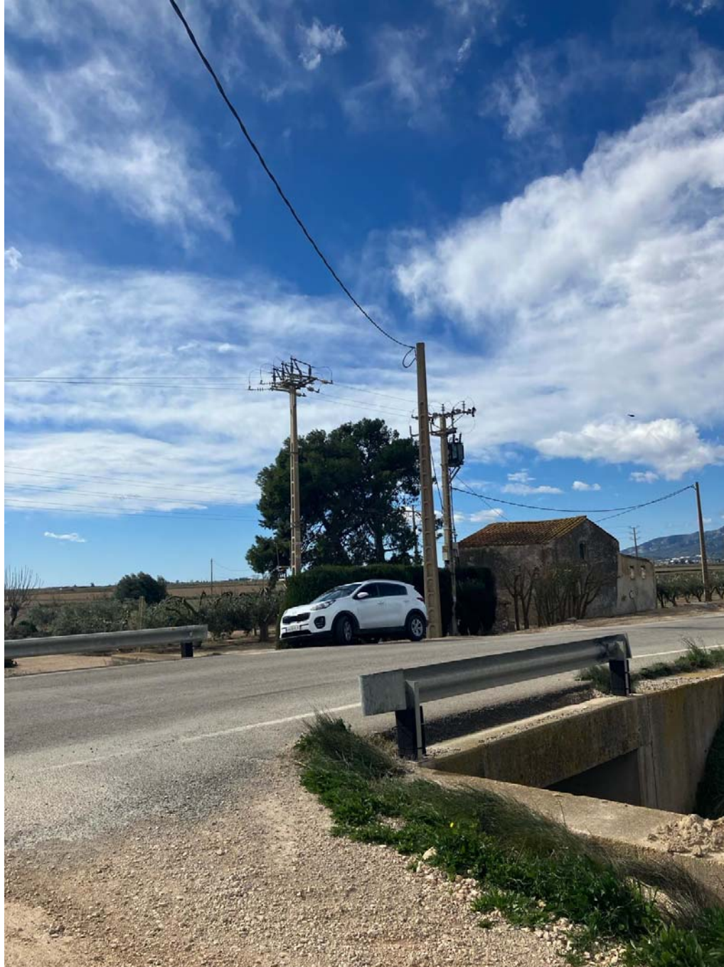
Figura 8.- Xarxa elèctrica de Fecsa-Endesa a la TV-3406.
