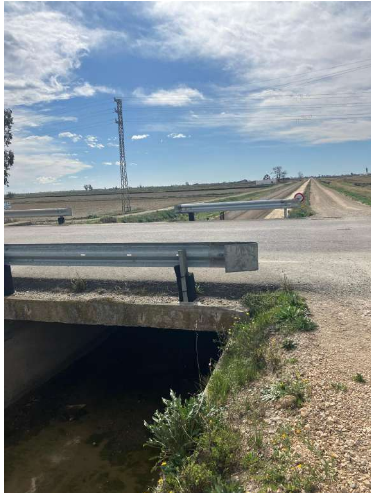
Fotografia 1.- Vista pont sèquia Agulla desde TV-3406.
