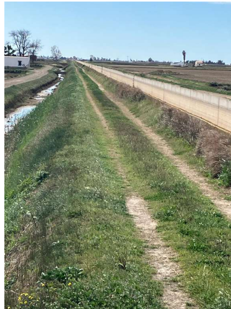
Fotografia 5.- Camí de servei per on es construirà rasa per cablejat elèctric.
