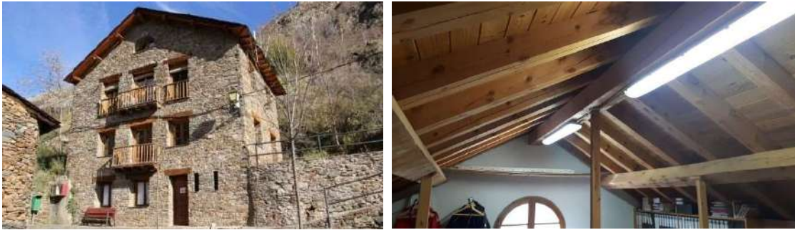
Imatge 8. Interior i exterior de l'edifici de l'Ajuntament de Lladorre.
