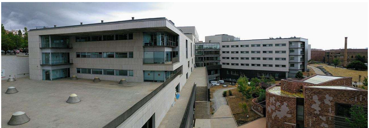
Blocs A i B
