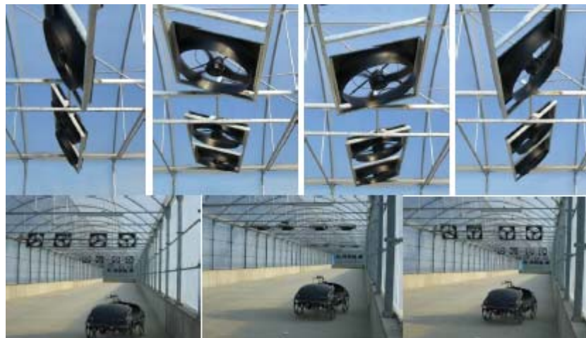
Ventiladores recirculación
