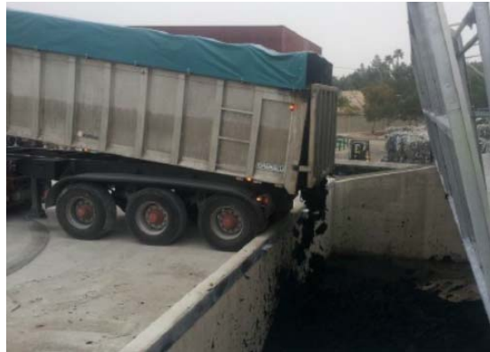
Descarga de lodo en bunker
