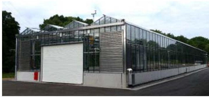
Planta de secado con cubierta de vidrio aislante
