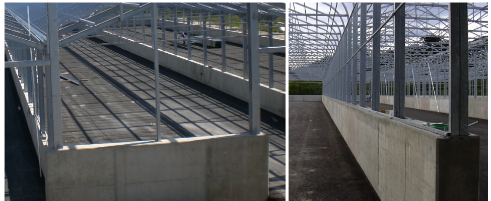
Muro con estructura de acero superpuesta
