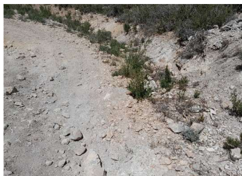
Fi construcció cuneta
