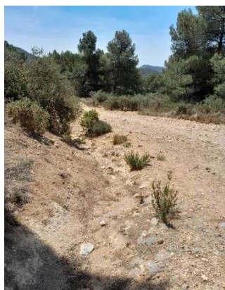
Inici repàs cuneta
