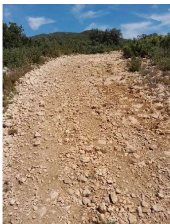
Tram 2: pedregositat elevada
