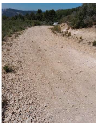
Inici construcció cuneta
