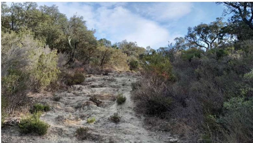
Obertura d'àrea estratègica del Coll de Medàs Sender exemple que, un cop acabats els treballs, haurà de quedar lliure de restes vegetals
