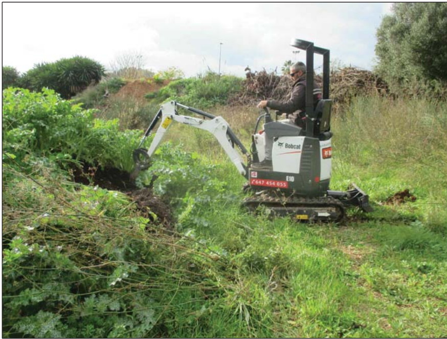
EMPLAÇAMENT CALICATA C-11
