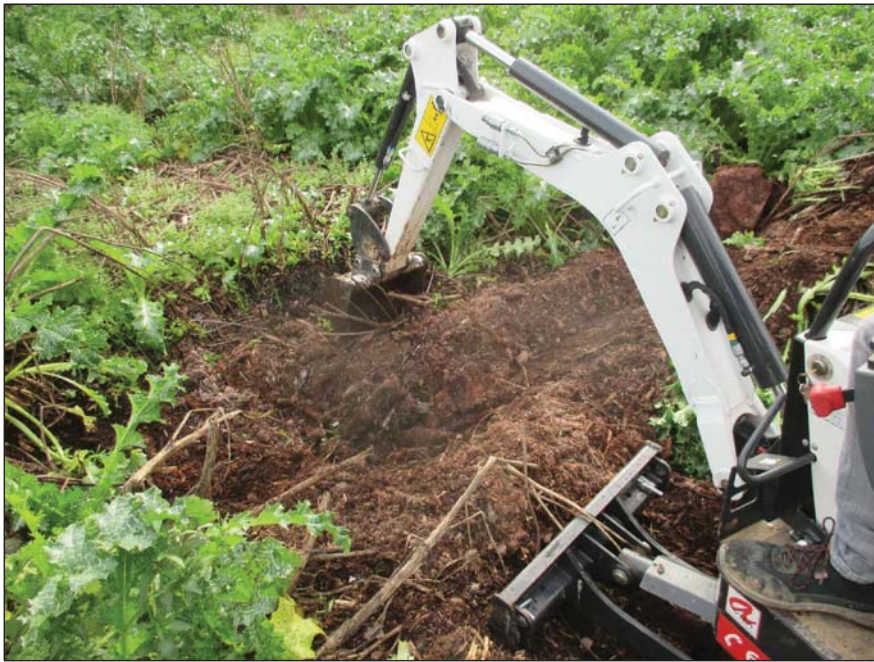
EMPLAÇAMENT CALICATA C-07
