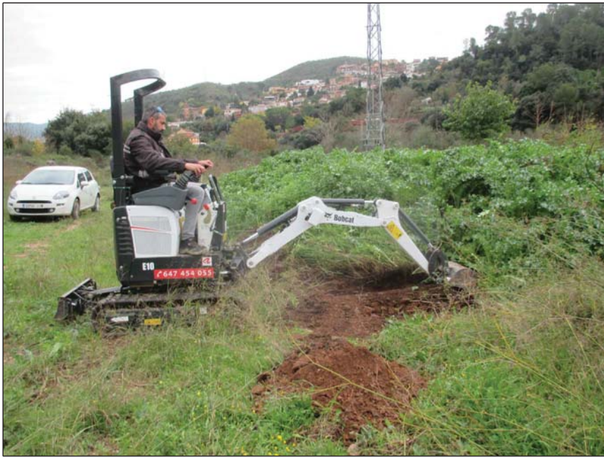
EMPLAÇAMENT CALICATA C-13
