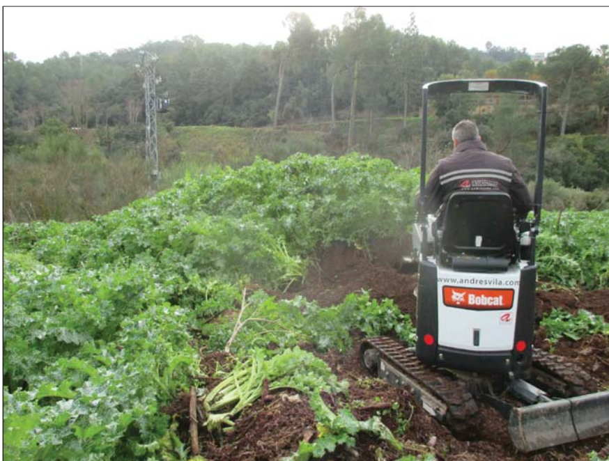
EMPLAÇAMENT CALICATA C-06
