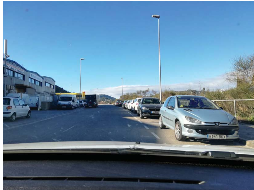
Fotografia 8: Vista del carrer A del polígon de Sant Vicenç dels Horts per on es projecta el traçat de la conducció de fosa dúctil DN400
