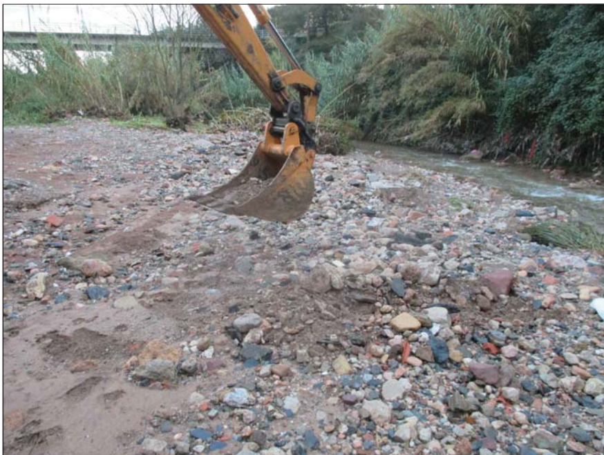
EMPLAÇAMENT CALICATA C-14
