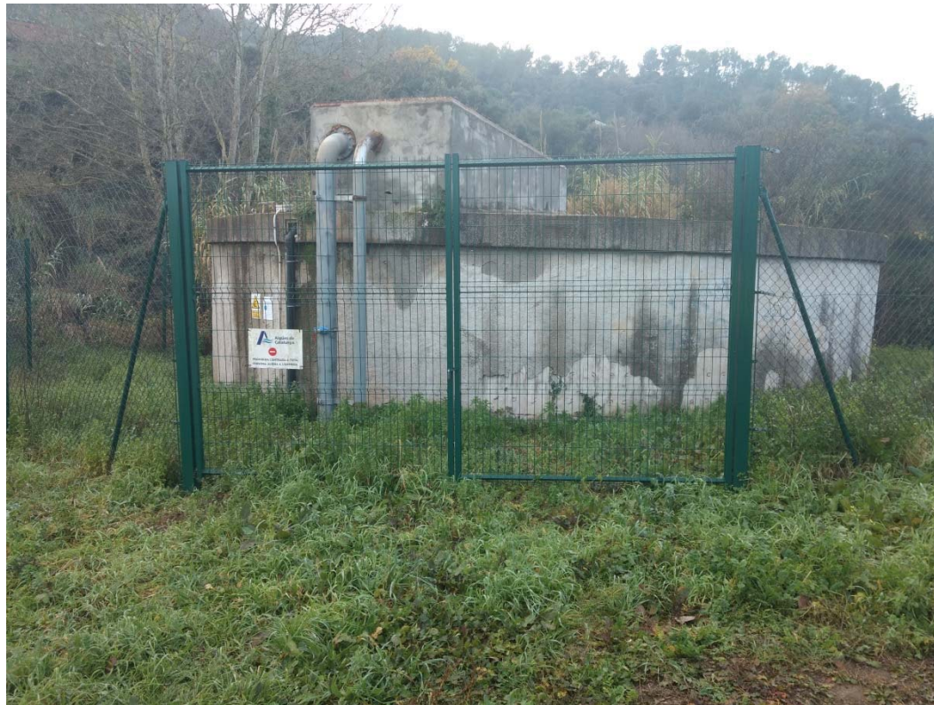
Fotografia 18: Dipòsit de Granja Garcia
