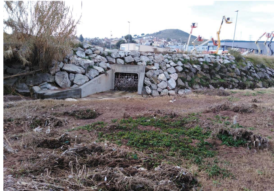
Fotografia 7: Protecció d'escullera al marge dret de la riera de Cervelló. En aquest indret es realitzarà un encreuament total de la llera i es pujarà al carrer A del polígon de Sant Vicenç dels Horts.
