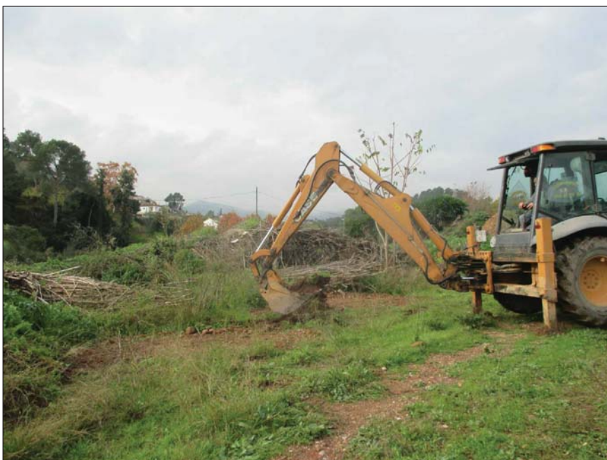
EMPLAÇAMENT CALICATA C-16
