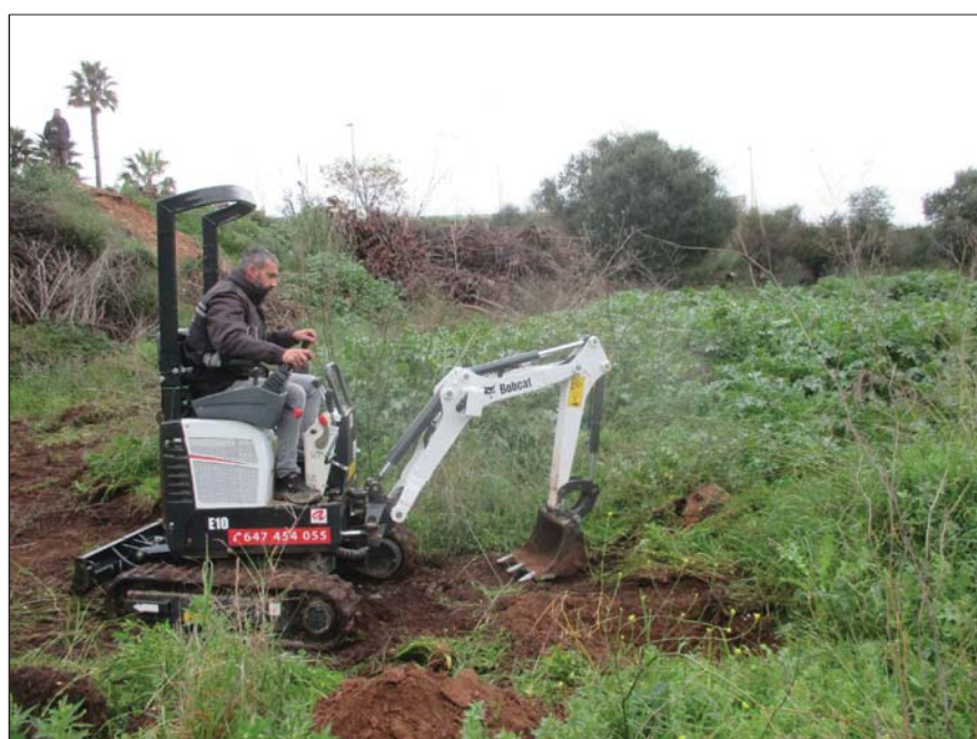
EMPLAÇAMENT CALICATA C-04
