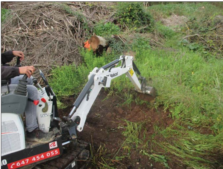
EMPLAÇAMENT CALICATA C-09
