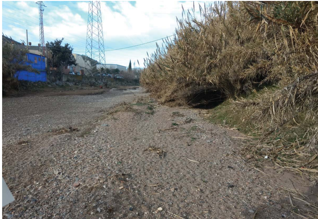
Fotografia 5: Llera de la riera de Cervell aigües del pont de la N-II.
