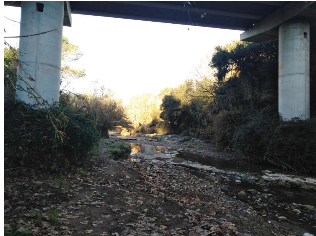
Fotografia 15: Llera de la riera de Cervelló a l'encreuament amb el pont del carrer Llobregat
