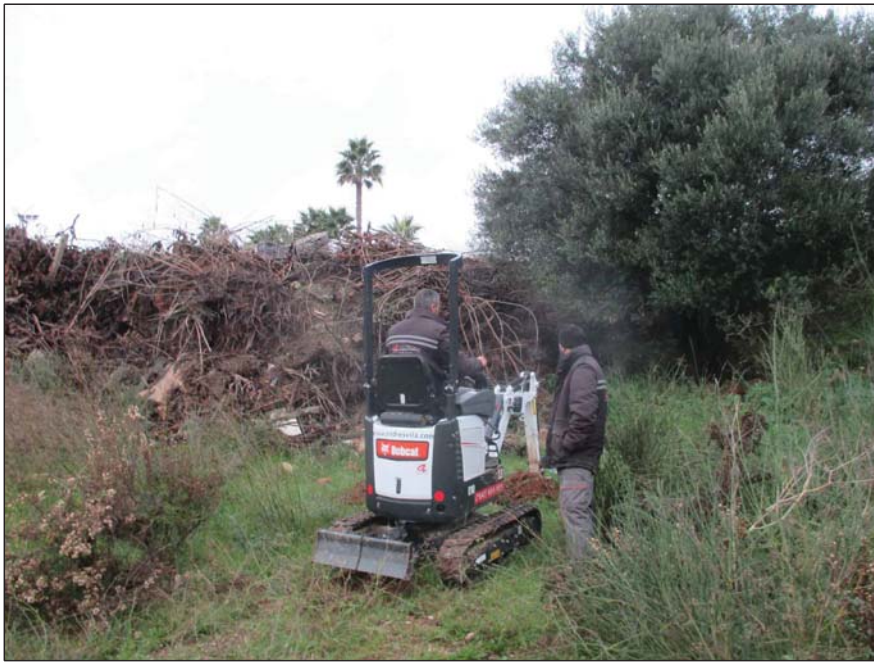
EMPLAÇAMENT CALICATA C-01
