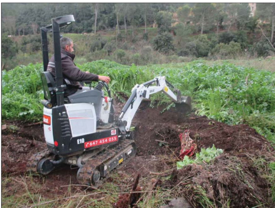
EMPLAÇAMENT CALICATA C-02
