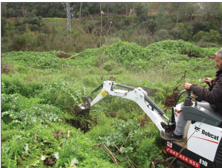
EMPLAÇAMENT CALICATA C-10
