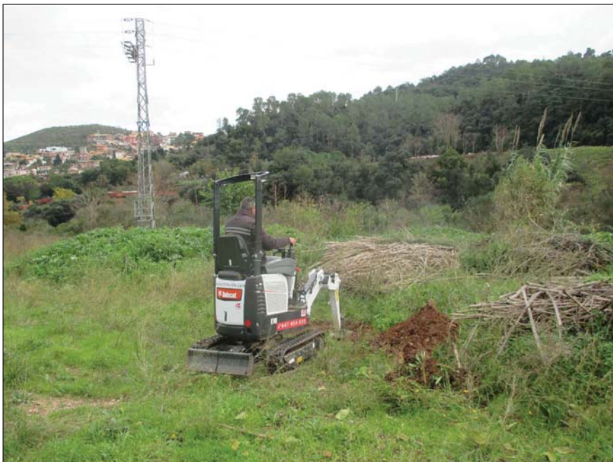
EMPLAÇAMENT CALICATA C-12
