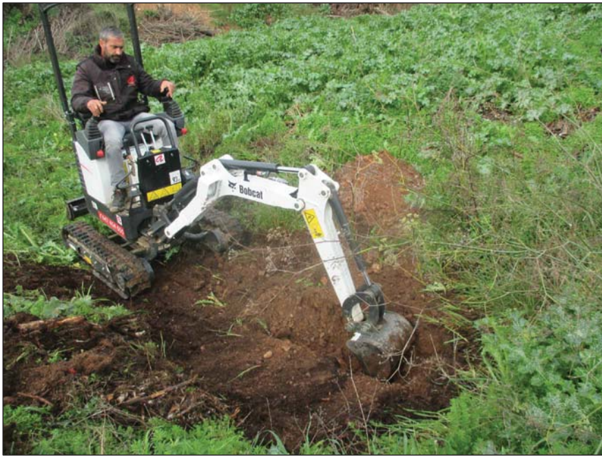
EMPLAÇAMENT CALICATA C-05
