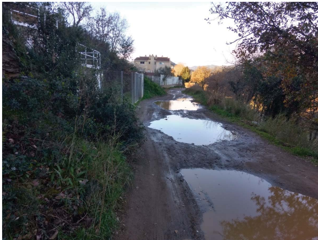
Fotografia 10: Vista del vial que comunica el dipòsit "Planeta Azul" (a l'esquerra de la imatge es veu el tancament perimetral) amb el polígon industrial de Sant Vicenç dels Horts
