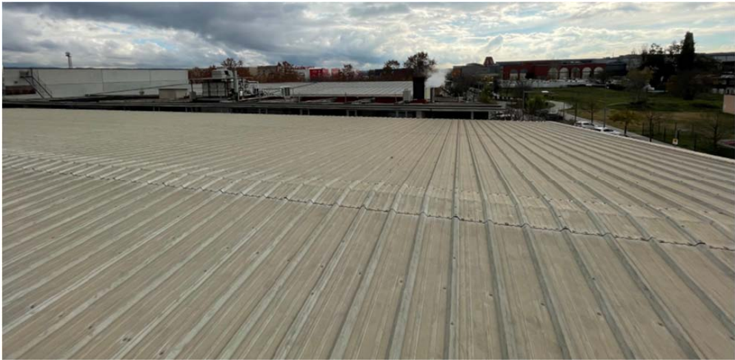
Foto 1. Coberta PISTA POLIESPORTIVA
