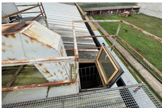
Foto 3. Detall accés a coberta
