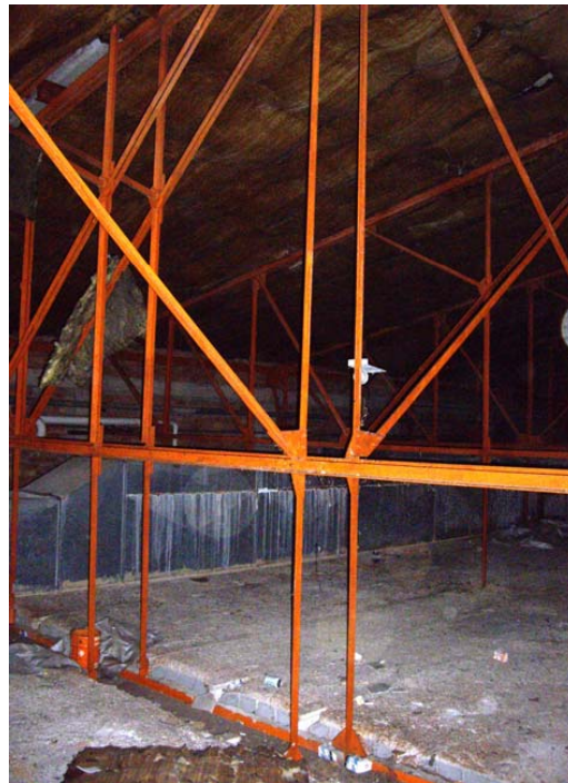
figura 2 – encavallada doble
