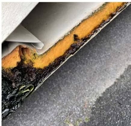
Foto 2. Detall panell coberta.
