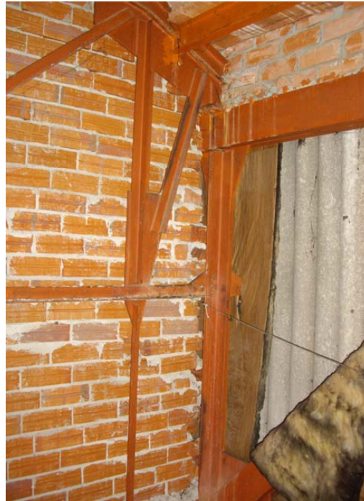
figura 3 – Unió cantonada encavallada i gelosia.
