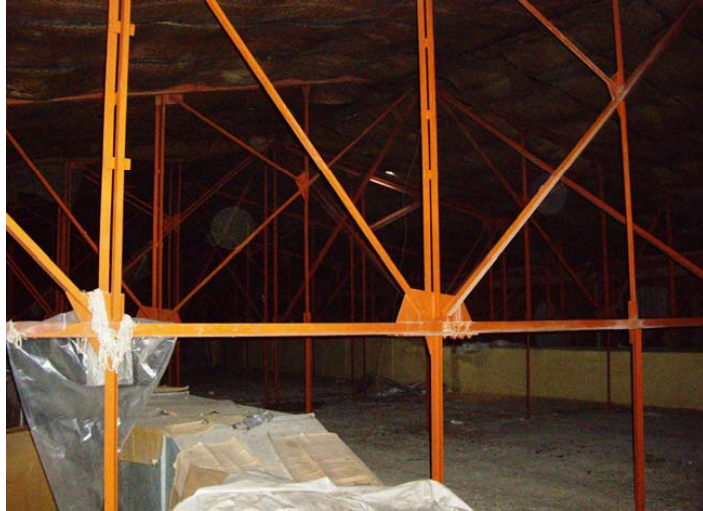
figura 1 – encavallada simple
