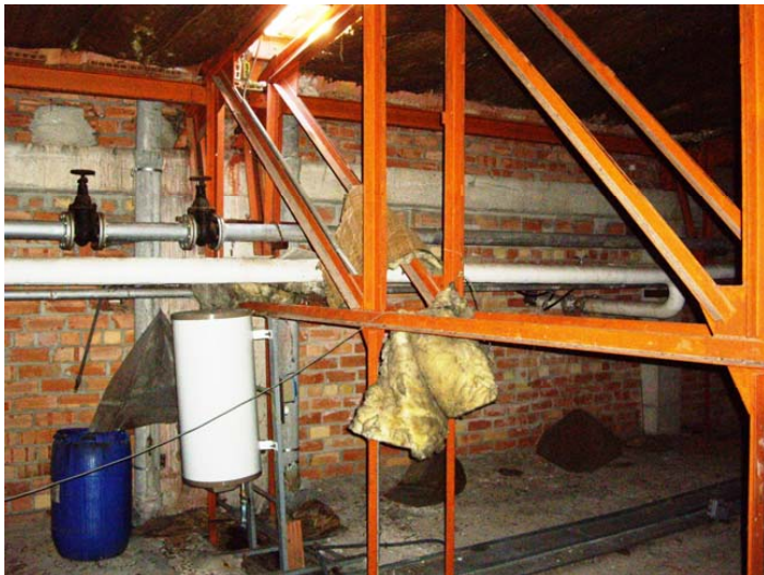
figura 5 – Recolzament encavallada sobre jàssera de formigó.
