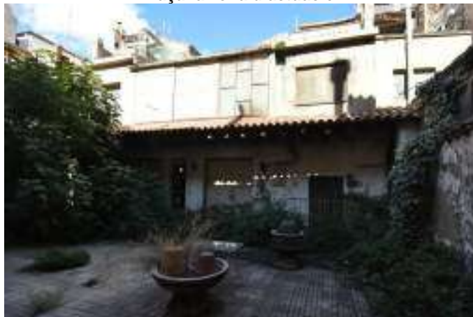
Façana zona d'actuació
